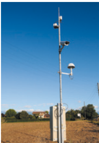
Station de mesures météorologiques
