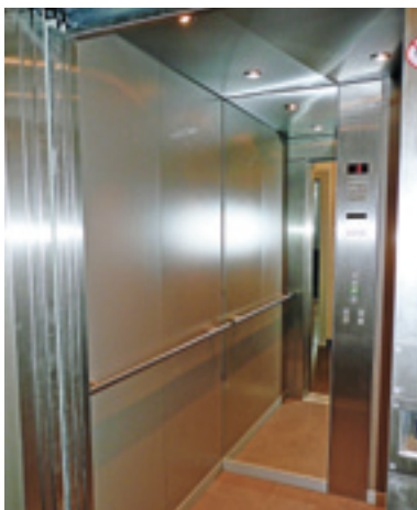
Ascenseur desservant l'ensemble du bâtiment.
