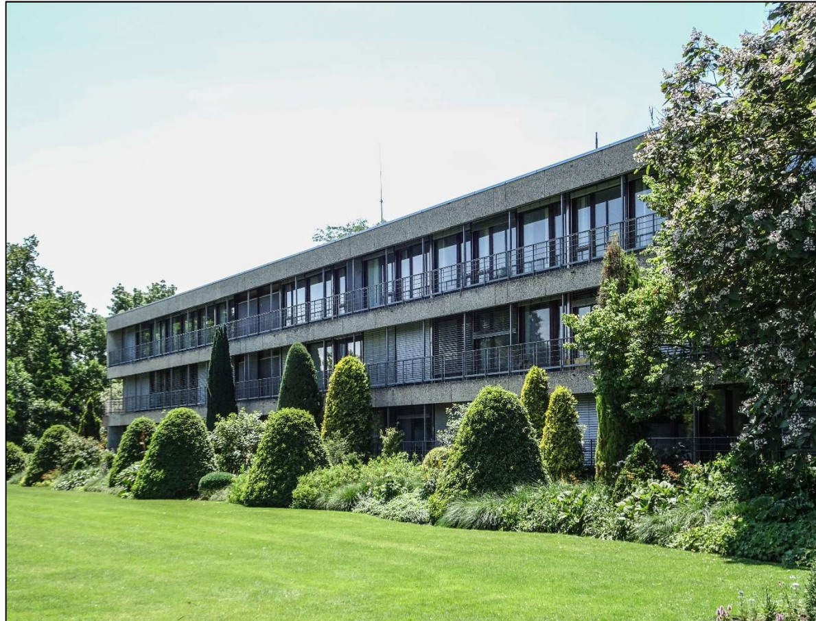
Embrouchis 2-4, centre horticole de Lullier, bâtiments administratif et des salles de cours, Alfred Damay et Michel Frey, architectes, Walter Brugger, paysagiste, 1970-1975
